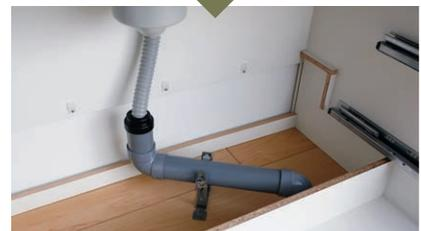
配管スペースの点検口は外せるので、キッチン設置後の配管工事も簡単。既存の配管を上手に利用できるのでリフォームコストも抑えられます。
